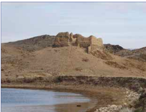
Das Wasserreservoir unter der alten Lehmburg
